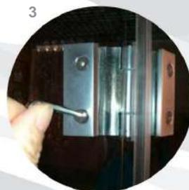
**Nota:** la porta è pesante. Quando si installano, è consigliabile sostenerle con un cuscinetto solido e di dimensioni adeguate, in modo da poter posizionare e stringere le cerniere in modo preciso e senza troppi sforzi.
