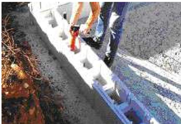
Una volta messi tutti i tondini, stenderne uno in orizzontale, lungo tutto il perimetro della vasca, per ogni piano di casseri costruito.
