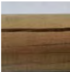
Cracks/Grietas/Fente/Risse/ Crepe/ Barsten/Fendas
