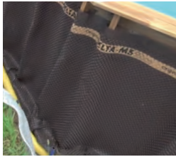
Alveolar protection in HDPE Protección alveolar en PEAD Protection alvéolaire en PEHD Alveolar Schutz in PEHD Protezione alveolare in PEAD Beschermdende HDPE-noppenfoli Proteção alveolar em PEAD
