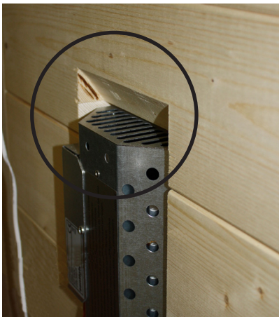
Afb. 1: Ventilatiesleuven vrij laten
