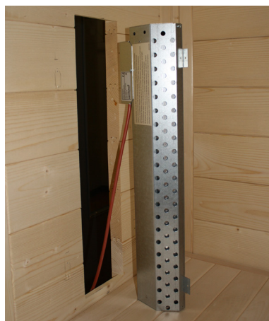
Obr. 2: Poloha připojovací krabice
