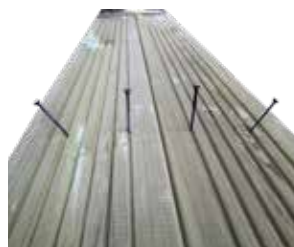
Fixing of the edges Colocación de las playas Fixation des margelles Befestigung der Ränder Fissaggio dei bordi Bevestiging van de randen Fixação dos bordos
